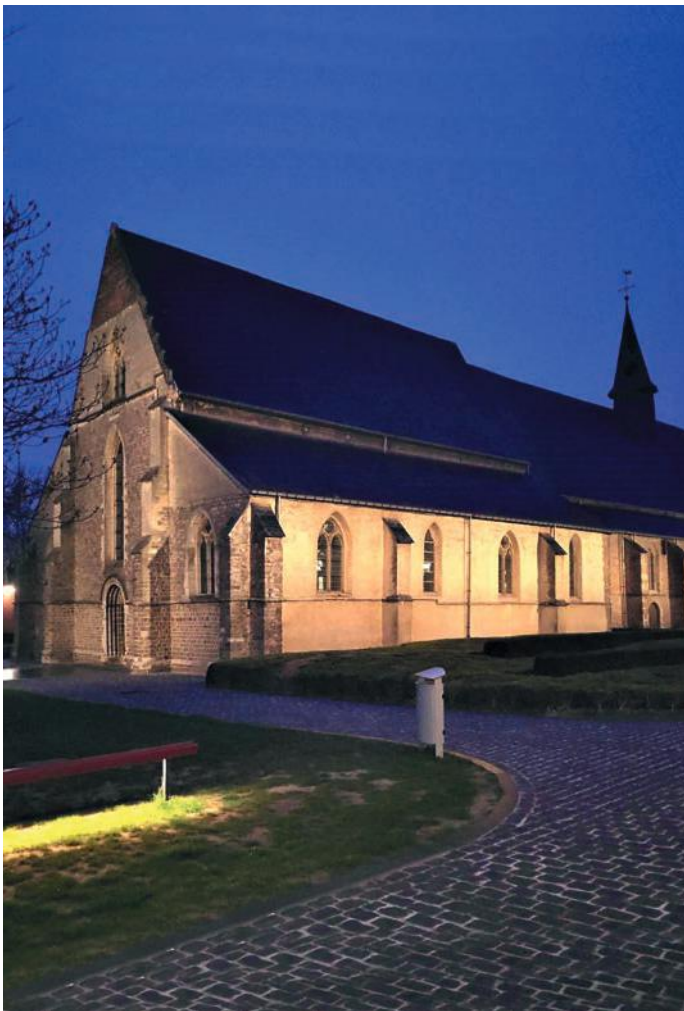
Begijnhofkerk, Sint-Truiden, Belgium. Luminaire: led.modular ©Hoffmeister
